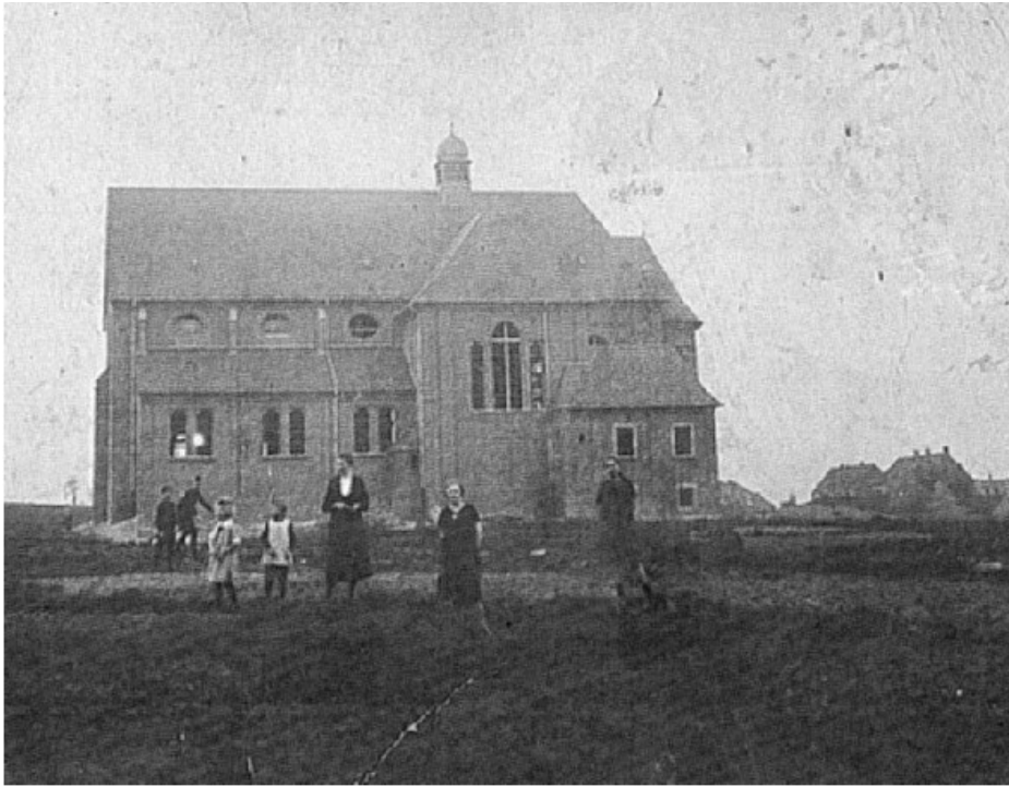
1927: Die St. Marien-Kirche im Rohbau
