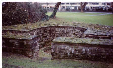
Fundamente des türmeflankierten Osttores
