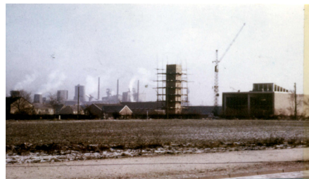
Die Baustelle mit der Zeche Jacobi
